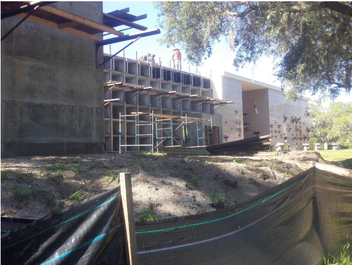
Flagler Mausoleum - 6th Floor Concrete Pour
